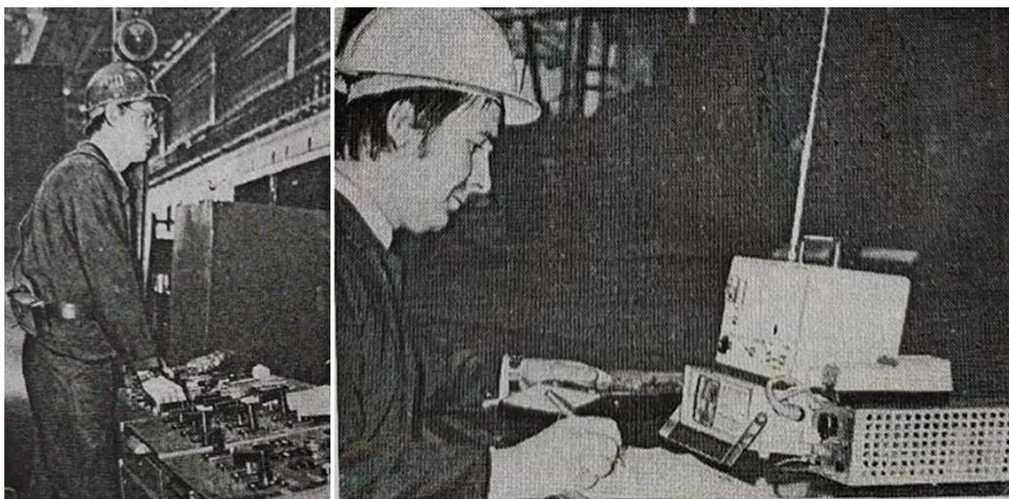
*Рисунок 5.8 – Четырехканальная биотелеметрия ЭКГ у операторов цеха холодного проката Верх-Исетского металлургического завода. На поясе рабочего виден закрепленный прибор. Исследователь использует приемник, магнитофон и визуальный регистратор (обращает на себя внимание ручная запись определенных показателей). Источник: Свердловский научно-исследовательский институт гигиены труда и профзаболеваний. К 50-летию со дня организации (1929–1979). Проспект. Свердловск, 1979. С. 38.*
