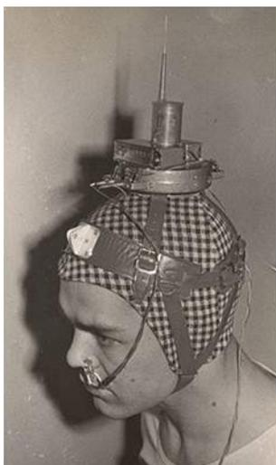
*Рисунок 4.8 – Двухканальный биотелеметрический прибор на базе «ТЭК-1», передающая часть на испытуемом (РГАС Ф. Р-179, Оп. 2–1, Д. 828, Л. 74; публикуется впервые)*
