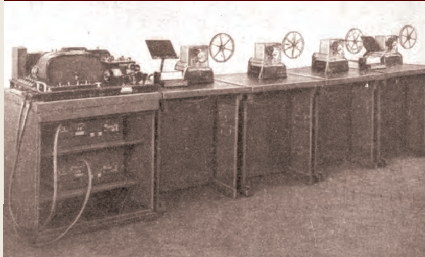
Телеграфный аппарат Бодо полевого типа
